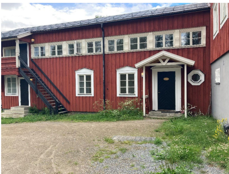
Figur 16. STF:s anläggning från 1928 (Foto: WSP 2022).
