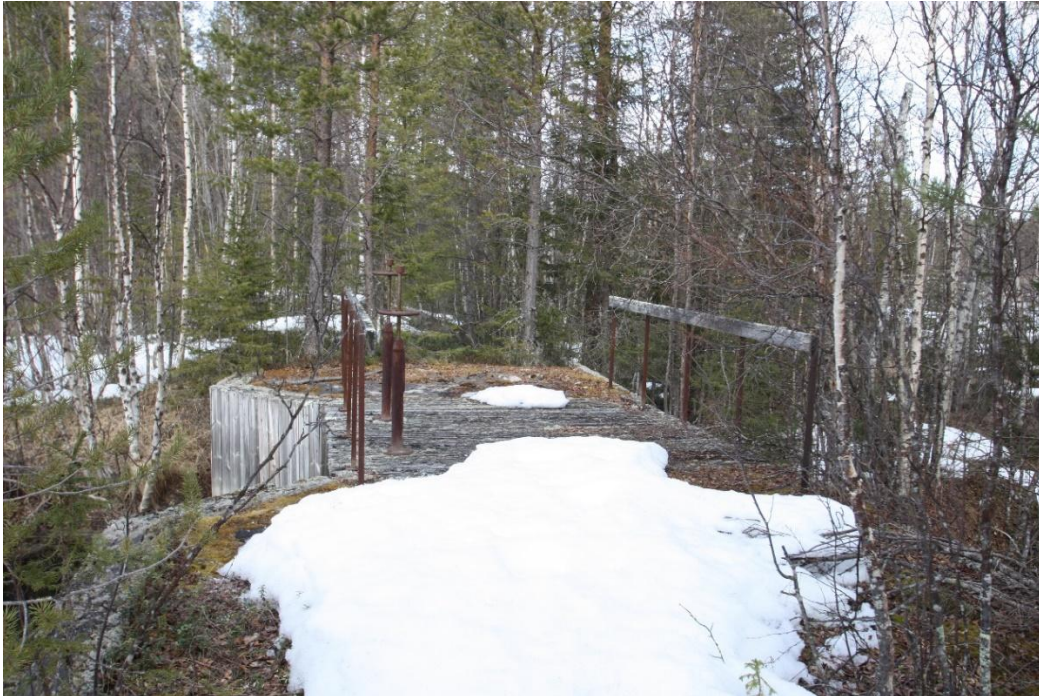
Foto 2, Dammkrön med brobana och skruvreglering. (Mark och huskonsult, 2014)
