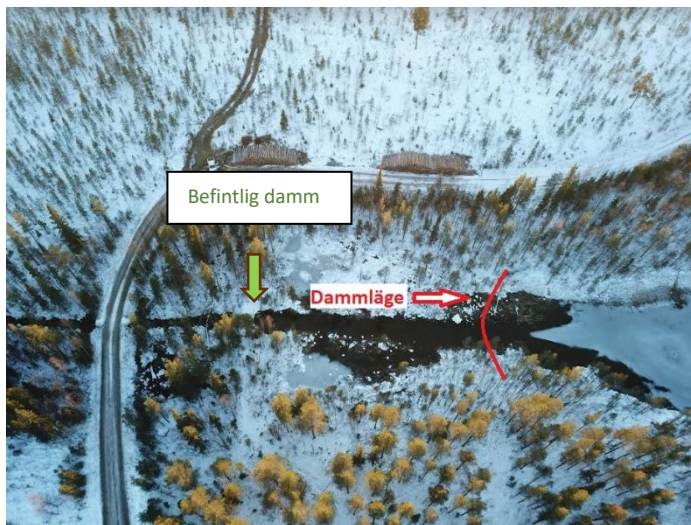
Foto 6. Befintlig damm och nytt dammläge
