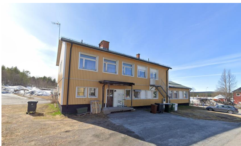
Figur 5 Befintlig byggnad inom planområdet sett från öster.
