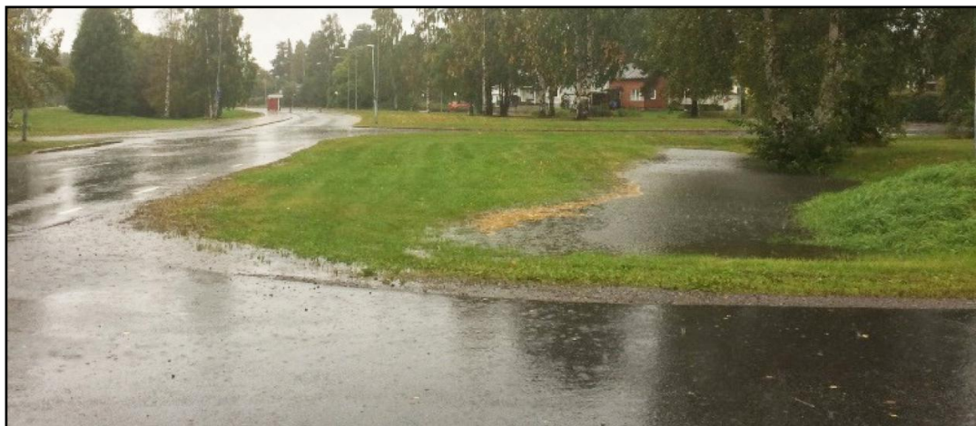
Figur 4. Svackdike efter skyfall. Källa: (Svenskt Vatten, 2019)
